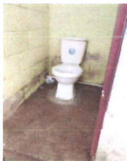
SERVICIOS SANITARIOS SUSTITUCION DE SANITARIOS, CON ACCESORIOS
