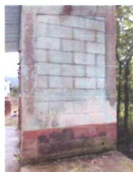
PINTURA PINTURA EN MUROS EXT E INTERIOR EN SANITARIOS
