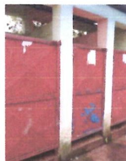
PUERTAS MANTENIMIENTO DE PUERTAS DE SANITARIOS
